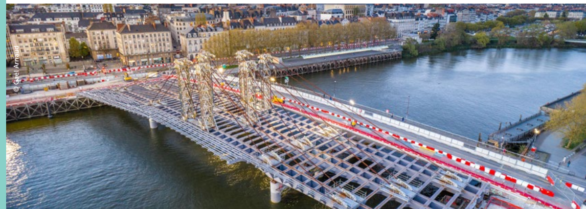
L'installation du tablier sur ses appuis les 25 et 26 mars.
